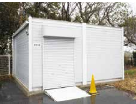
滝乃川学園の備蓄倉庫
